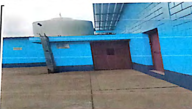
foto3: Sustrucción de puerta.
