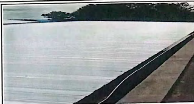
foto 2: Sustrucion de techo.
