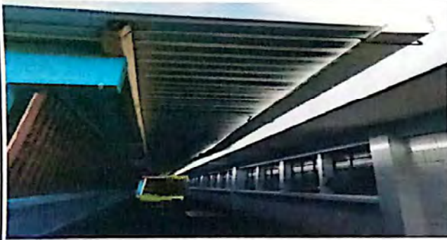
FOTO 7: SUSTITUCION DE CANALES Y BAJADAS DE AGUA
