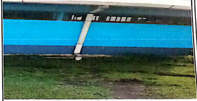
FOTO 8: SUSTITUCION DE CANALES Y BAJADAS DE AGUA
