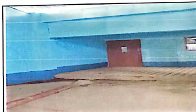
Foto 4: Sustrucción de puerta.
